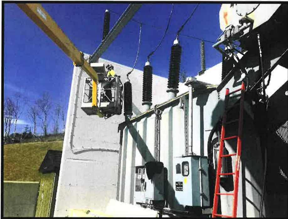
Skifte av gjennomføringer for T4.
