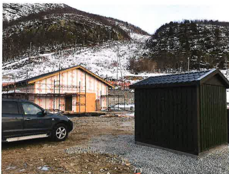
Ny trafokiosk Glomfjord VBA. Prøvebygg Markus.
