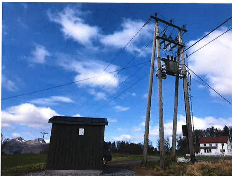
Skifte fra mastetrafo til trafokiosk Halsos 2.
