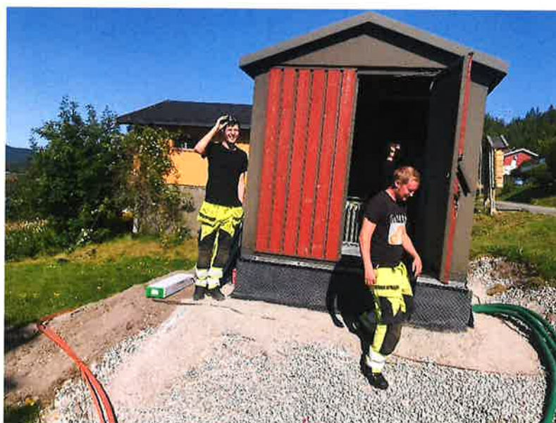
Skifte til ny trafokiosk Neverdal Boligfelt.
