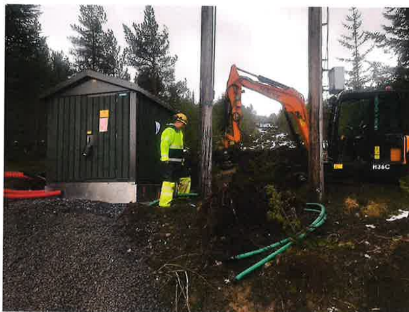
Skifte fra mastetrafo til trafokiosk Halsos 1.
