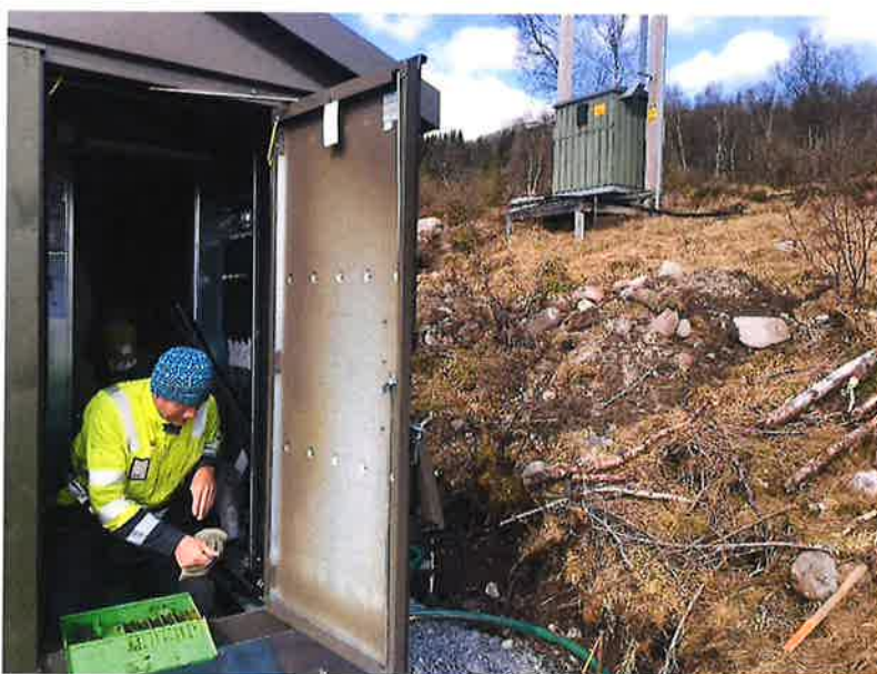
Skifte fra mastetrafo til ny trafokiosk Saura.
