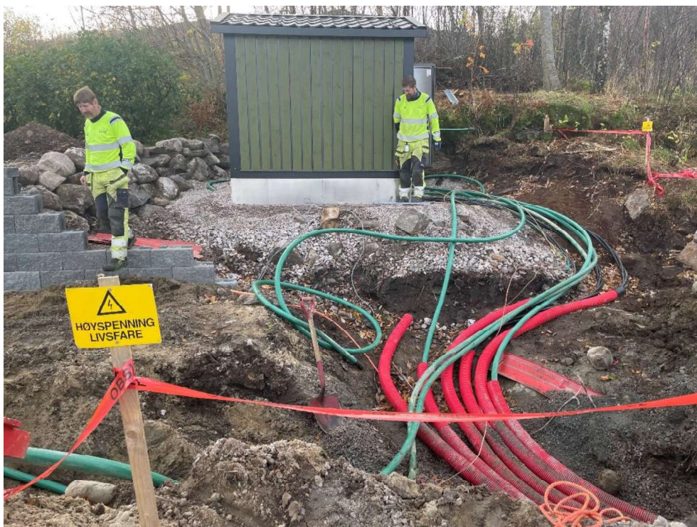
Våtvik 1. Siemens nettstasjon med 315 kVA trafo er satt i drift, erstatter en gammel kiosk
