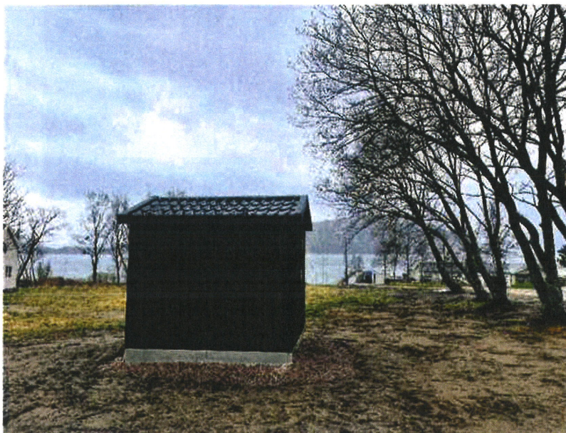
Fore 4. Ny Siemens nettstasjon med 200 kVA trafo er satt i drift. Erstatter trafo i mast.
