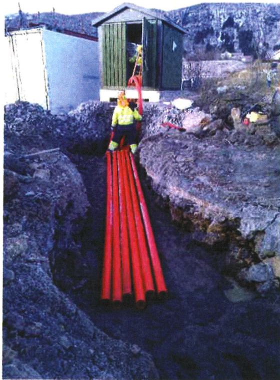
Fore Havneanlegg 2. Siemens nettstasjon med 315 kVA trafo 400 V satt i drift til ny slip.
