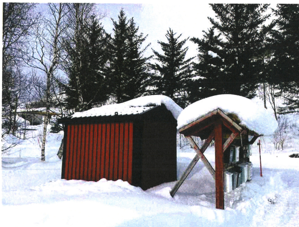
Spildra 3. Siemens nettstasjon med 315 kVA trafo er satt i drift, erstatter en gammel kiosk
