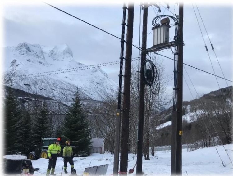
Rivning av linje og legging av kabel forbi rasoverbygg i Kilvik
