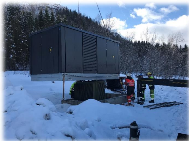
Flytting av spole fra Lysvatn til Spildra koblingsstasjon
