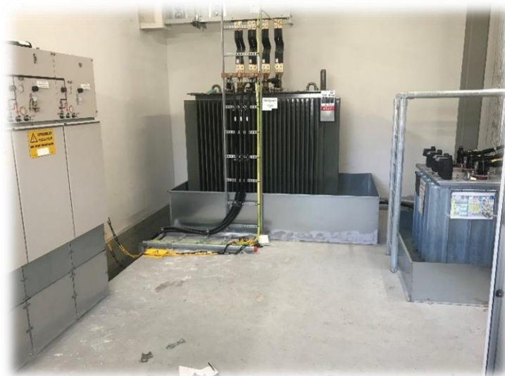
Flytting av trafo Norland Akva ved Skarsvann
