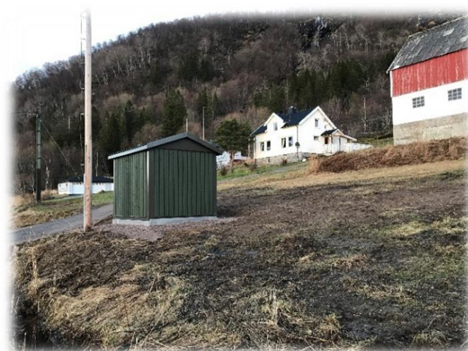
Ny trafokiosk på Gjerset erstatter gammelt mastepunkt
