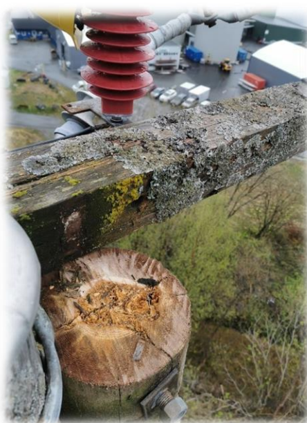
Utskifting av dårlige punkt på Forøy linja
