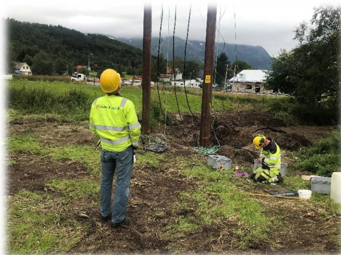
Flytting av kabelmast i forbindelse med bygging av Enspire skole på Neverdal
